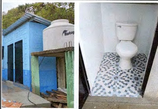
Foto 4: finalizacion de servicios sanitarios
