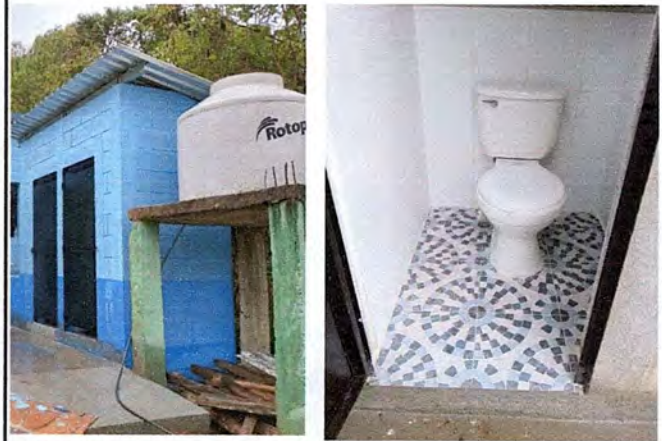
Foto 4: finalizacion de servicios sanitarios
